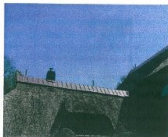
Kupferfirst in Olbg. mit Blitzschutz
