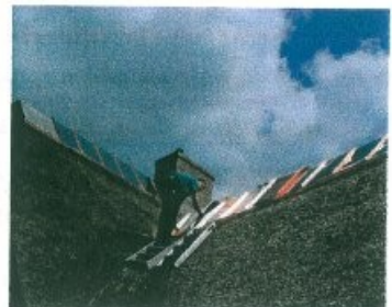
Kupferfirst in Olbg. mit Blitzschutz
